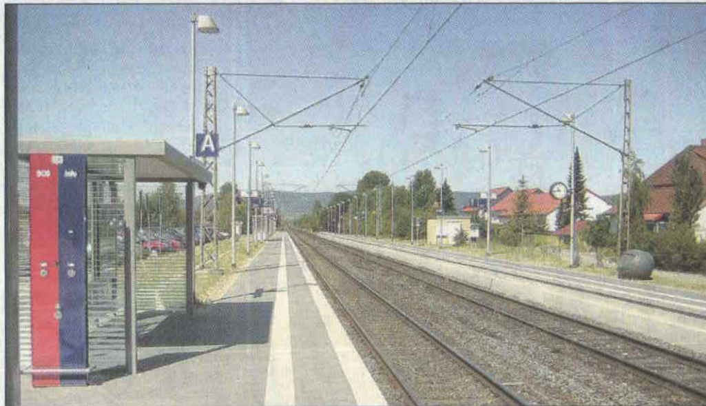
Bahnhof in Völkens: Die Bauarbeiten hat die Albert Fischer GmbH aus Elze ausgeführt.
