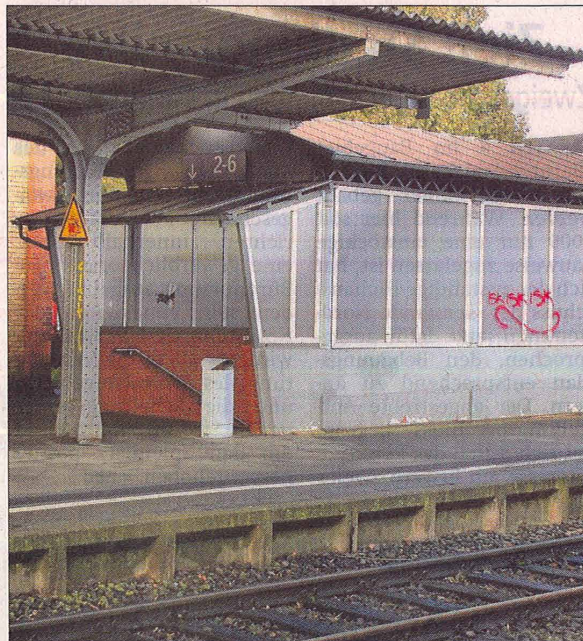
Die Dächer über dem Fußgängertunnel werden erneuert. Die Gleise werden angehoben, damit der Einstieg erleichtert wird.
