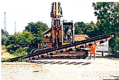
Stellvertretender Kommandeur des Schweren Pionierbataillons 130, Frank Abel, legt den "Spatenstich" zur Panzerverladeanlage. | Foto: A. Bora
