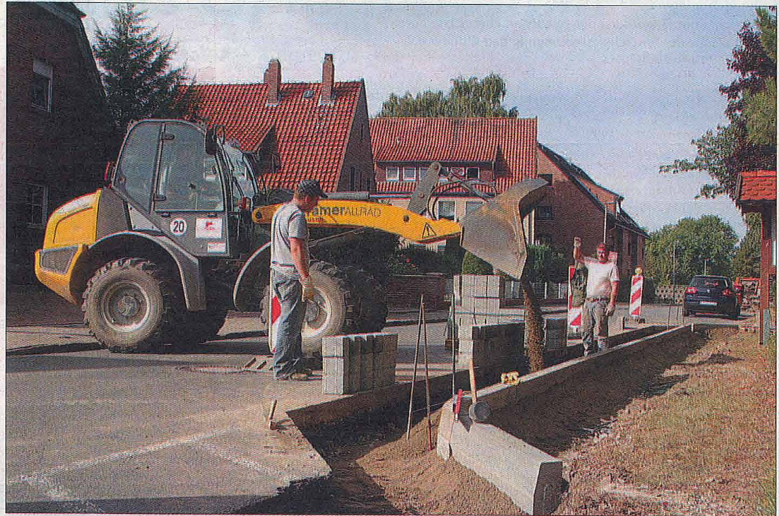
Mitarbeiter einer Elzer Baufirma setzen Kantsteine für die Hochborde an der Dorfstraße in Heisede. Harborth
