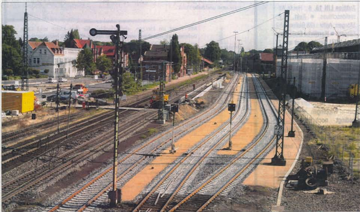
Auch am Sonntag wird auf dem Lingener Bahngelände gearbeitet, um den neuen Mittelbahnsteig fertigzustellen. Foto: C. van Bevern
