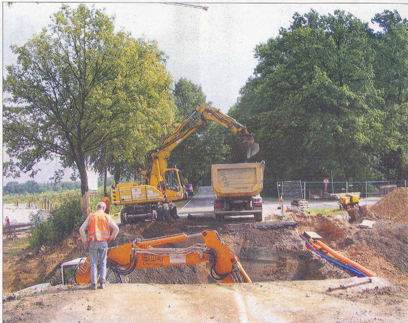
Die Bagger graben sich durch die Eldagsener Straße: Hier wird der Tunnel der Firma Octapharma entlangführen.
