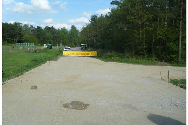
Herstellung Schottertragschicht beim Ausbau
