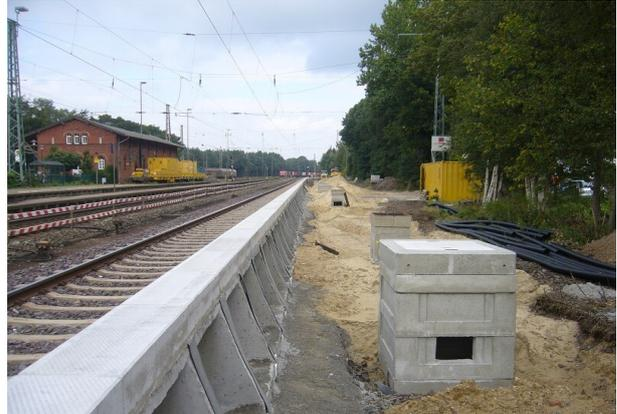
Neubau des Außenbahnsteiges in konventioneller Bauweise mit Schächten für die Kabeltrasse
