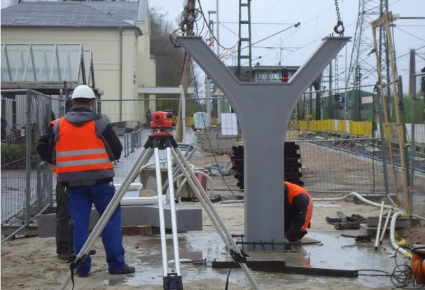
Einbau Stahlstütze der Fußgängerbrücke
