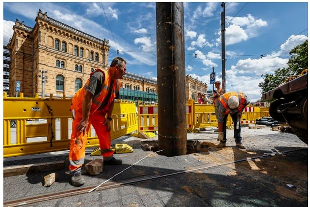
Ausrichten des Rohres während des Einbaus
