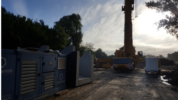
Mobilkran zum Einheben der Fertigteile
