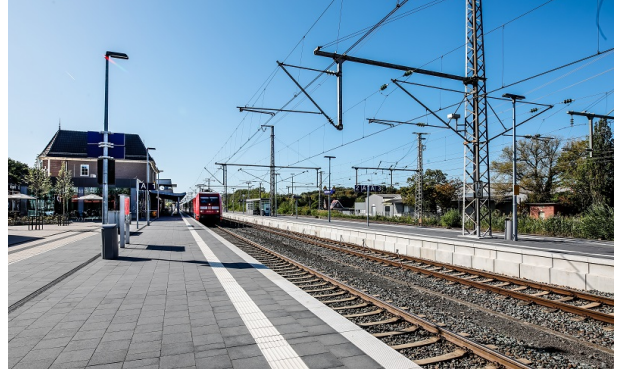
Ansicht Bahnsteig mit taktilem Leitsystem
