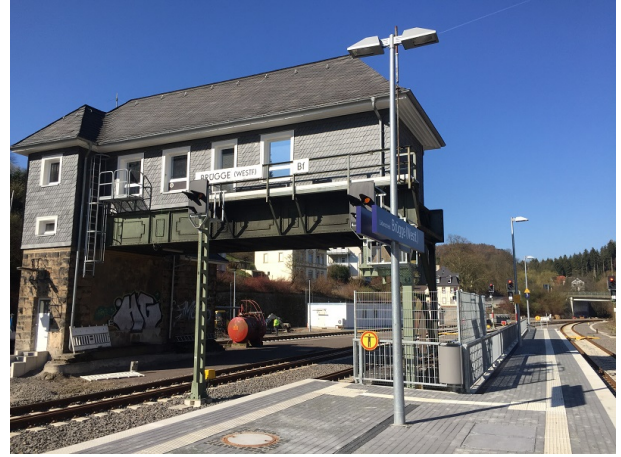
Zugang zum Mittelbahnsteig Gleis 1 und 2
