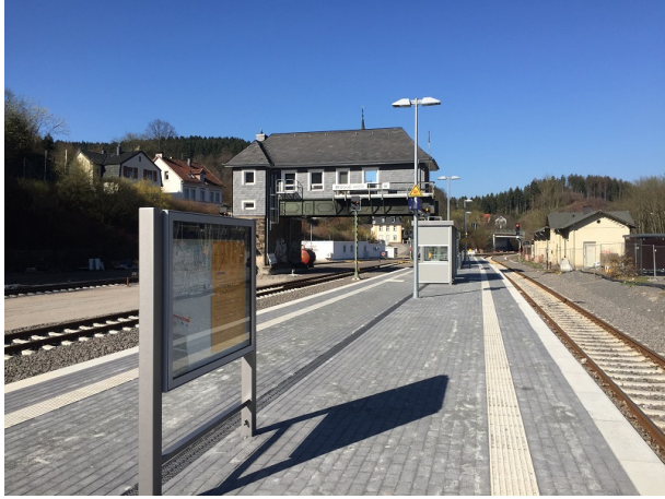
Mittelbahnsteig Gleis 1 und 2 mit Wetterschutzhaus
