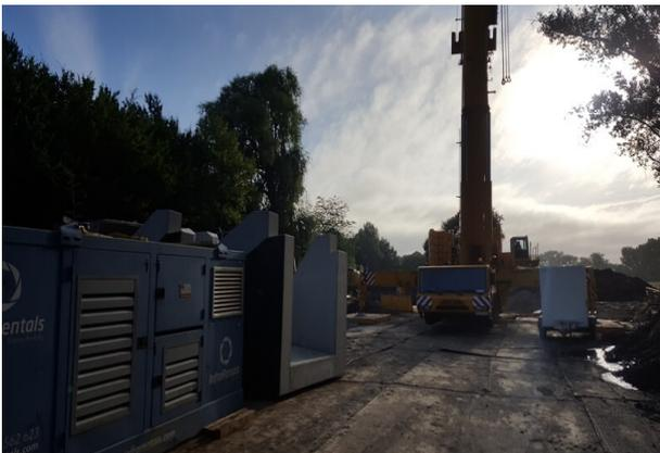
Mobilkran zum Einheben der Fertigteile
