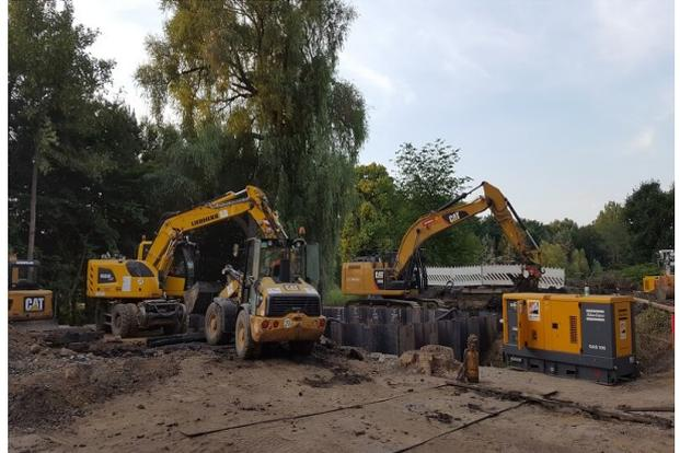
Maschineller Aushub im Verbaukasten
