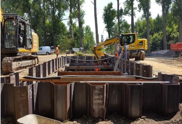
Maschineller Aushub im Verbaukasten
