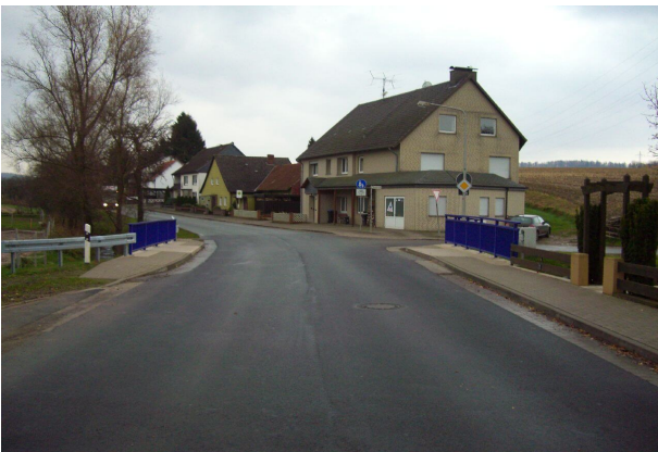
<p>Straßenoberbau und Durchlaß sind fertiggestellt</p>
