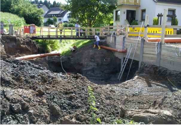
<p>Aushub der Baugrube und Herstellung Verbau</p><p>Profilierung des Geländes und der Böschungen</p>
