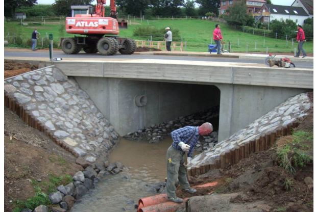
<p>Profilierung des Geländes und der Böschungen</p>
