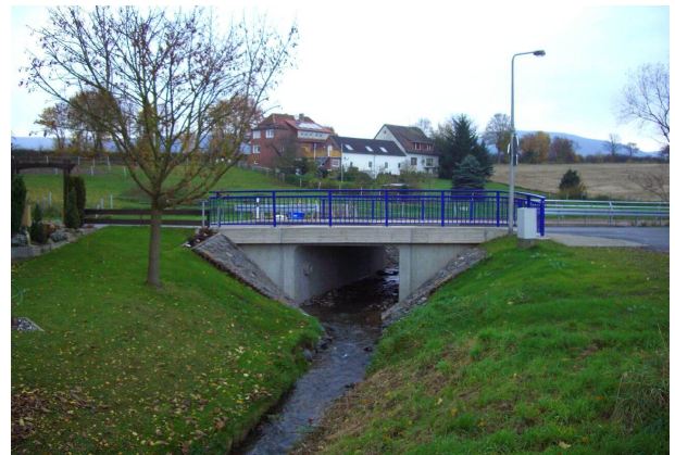
<p>Straßenoberbau und Durchlaß sind fertiggestellt</p><p>Durchlaß aus Betonfertigteilen mit Ortbetonkappe</p>
