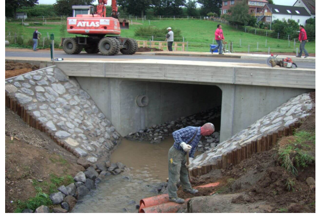
<p>Aushub der Baugrube und Herstellung Verbau</p><p>Profilierung des Geländes und der Böschungen</p>
