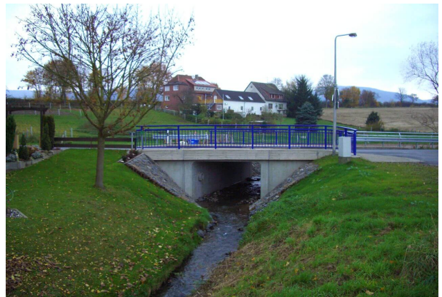
<p>Durchlaß aus Betonfertigteilen mit Ortbetonkappe</p>
