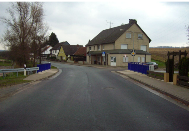
<p>Straßenoberbau und Durchlaß sind fertiggestellt</p><p>Durchlaß aus Betonfertigteilen mit Ortbetonkappe</p>
