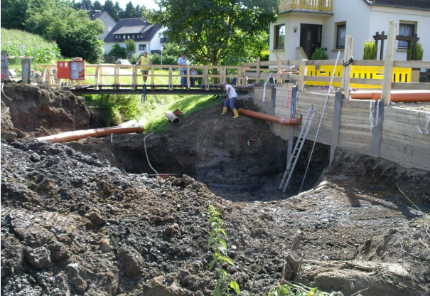
<p>Aushub der Baugrube und Herstellung Verbau</p>
