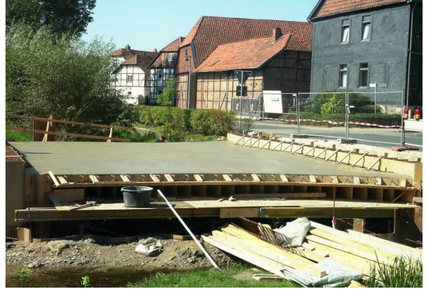
<p>Frischbetonierte Brückenplatte</p>
