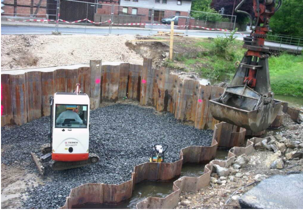
<p>Einbau des wasserdichten Spundwandverbau</p>
