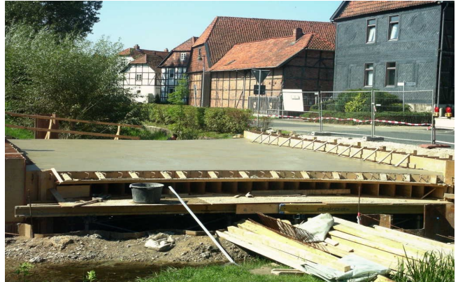
Frischbetonierte Brückenplatte
