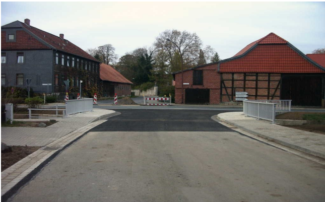
Ansicht nach Fertigstellung
