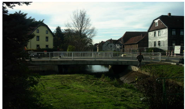
Ansicht nach Fertigstellung
