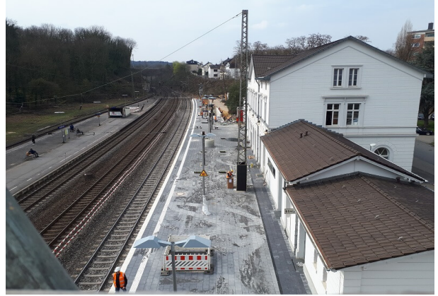
Pflasterarbeiten mit Blindenleitsystem Hausbahnsteig
