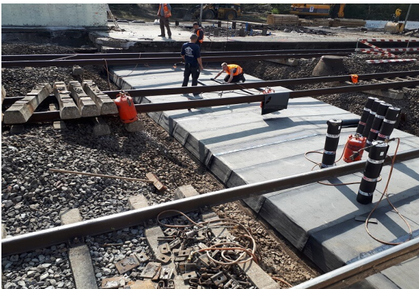
Abdichtung Bestandsdecke Personenunterführung
