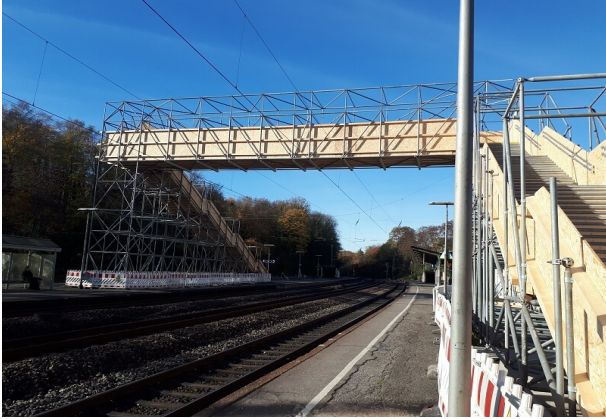
Provisorische Fußgängerüberführung über 3 Gleise
