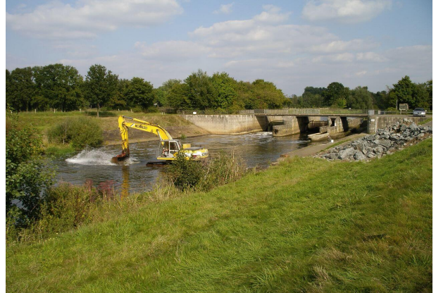
<p>Kolksicherung am Wehr Langlingen</p>
