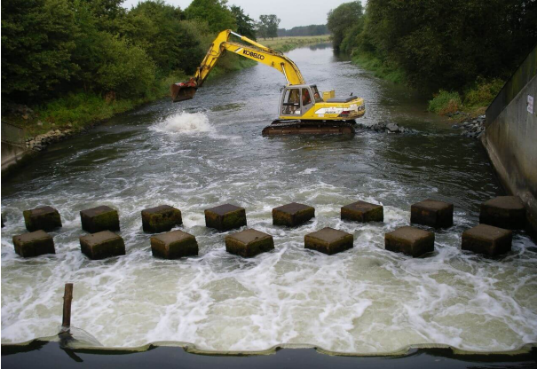
<p>Einbau von Wasserbausteinen am Wehr Osterloh</p>
