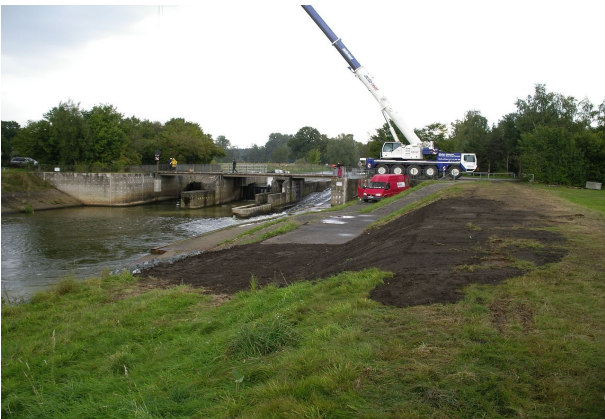
<p>Einbau der Störsteine mit Kran- und Tauchereinsatz</p>
