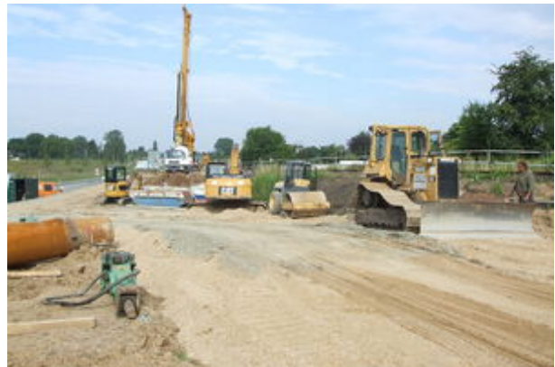
Erdarbeiten neuer Damm
