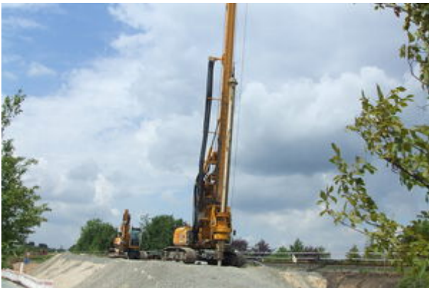
Herstellung Bohrpfehlwand
