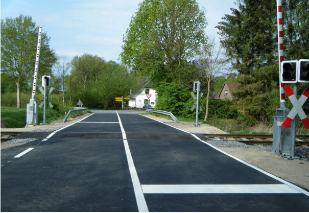
Neuer Bahnübergang Hemsen
