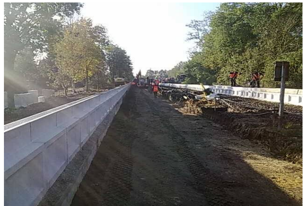
Herstellung Bahnsteig und Gleis 2
