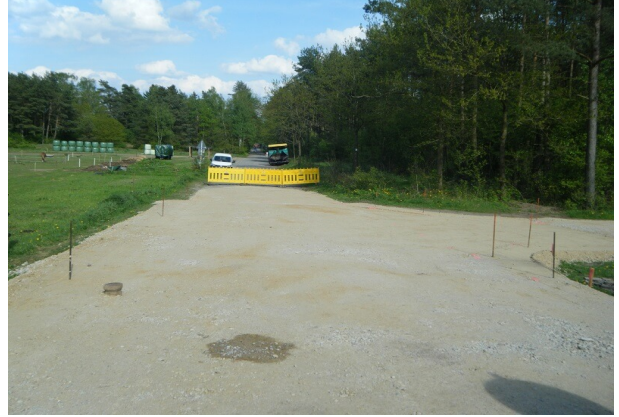
Herstellung Schottertragschicht beim Ausbau Bahnübergang
