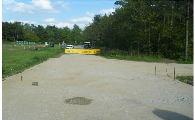
Herstellung Schottertragschicht beim Ausbau Bahnübergang
