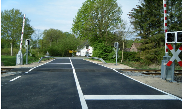
Neuer Bahnübergang Hemsen
