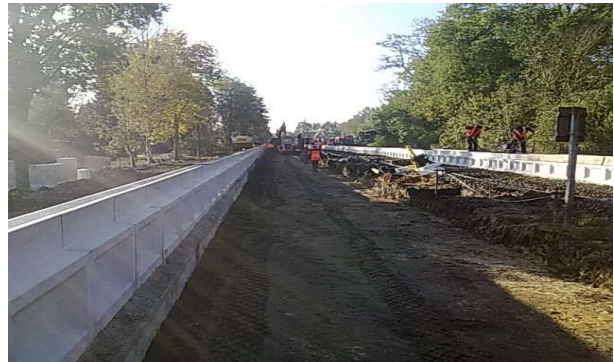
Herstellung Bahnsteig und Gleis 2
