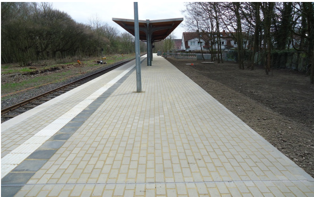
Blick vom Treppenaufgang zum Bahnsteig
