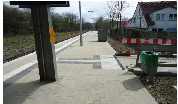
Hausbahnsteig Gleis 1, Zuwegung vom öffentlichen Straßenraum
