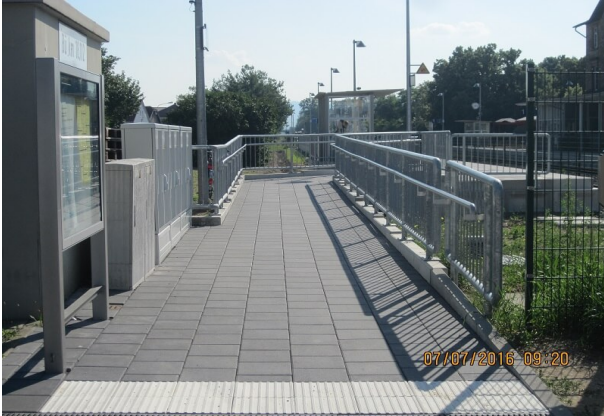
Zuwegung zum Außenbahnsteig
