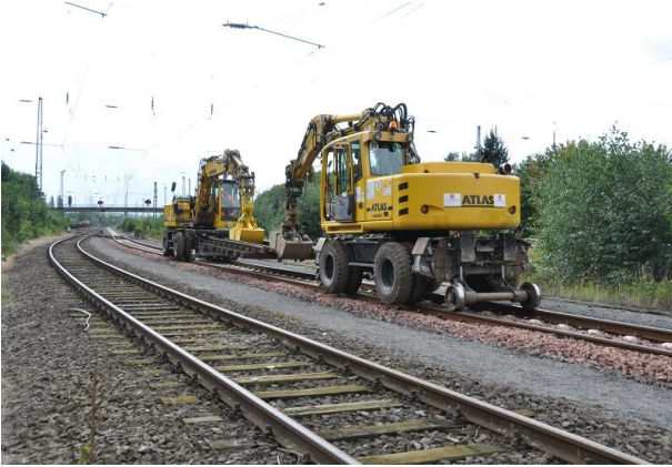
Rückbau der Weichen
