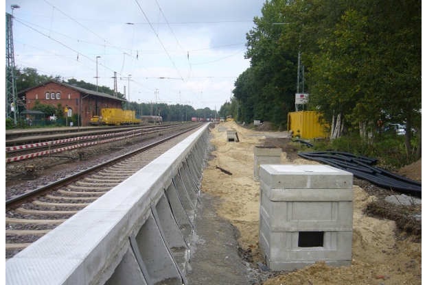
Bf Eystrup vor Beginn der Arbeiten des Außenbahnsteiges in konventioneller Bauweise mit Schächten für die K
