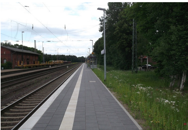
Fertiggestellter Bahnsteig mit Blindenleitsystem Fertiggestellter Bahnsteig mit Wetterschutzhaus und Beleuchtungsanlage
