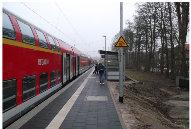
Fertiggestellter Bahnsteig mit Blindenleitsystem Fertiggestellter Bahnsteig mit Wetterschutzhaus und Beleuchtungsanlage
