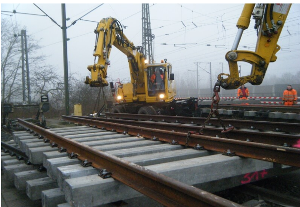
Vorarbeiten zur Weichenerneuerung
