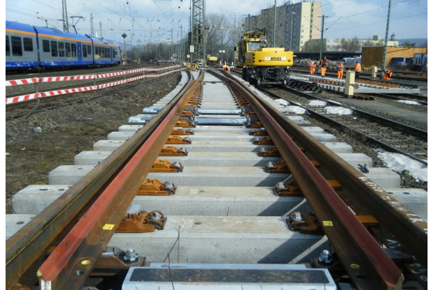
Vorarbeiten zur Weichenerneuerung
