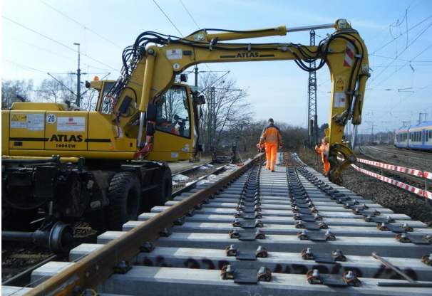
Vorarbeiten zur Weichenerneuerung
