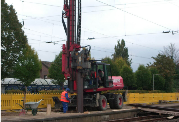
<p>Rammen des Spundwandverbaus</p>
