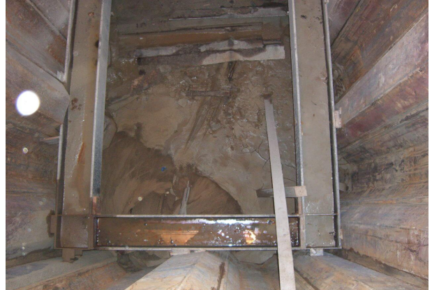
<p>Aussteifung und Aushub der Baugrube</p>
