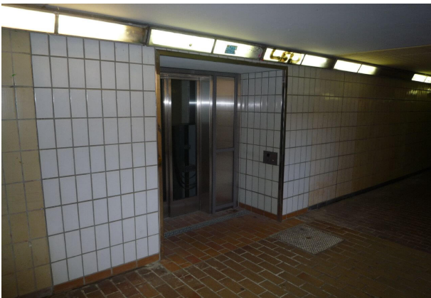
<p>Durchbruch in der Tunnelwand zum Fahrstuhl</p>
