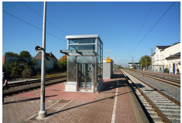
<p>Aufzug für den Zugang zum Mittelbahnsteig</p>
