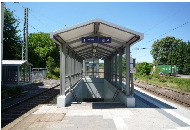
<p>Überdachung zum umgestalteten Fußgängertunnel</p>
