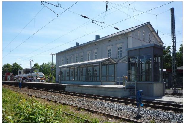
<p>Bahnhofsgebäude mit Tunnel und Aufzug</p>
