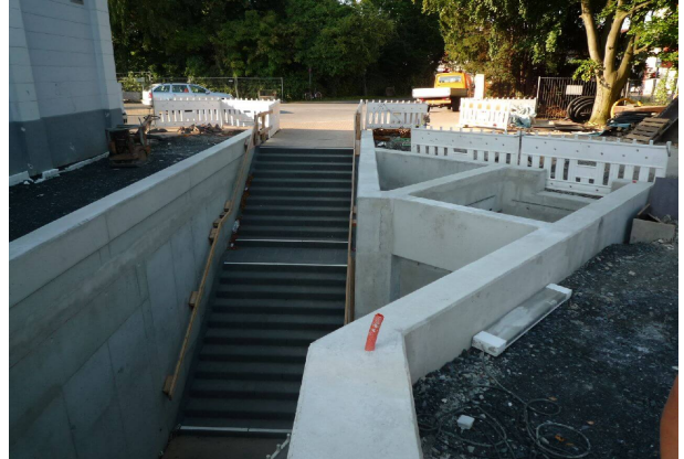
<p>Betonarbeiten für die neuen Zugänge</p>
