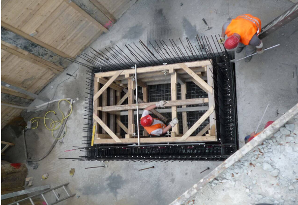
<p>Spezialtiefbau und Gründung für den Aufzug</p>
