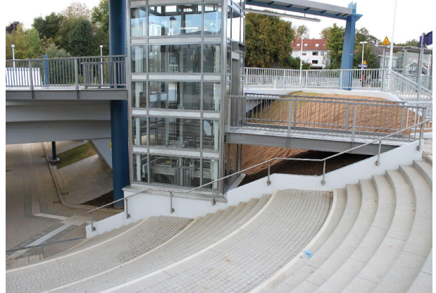
Treppenanlage Hauptzugang und Aufzugsschacht
