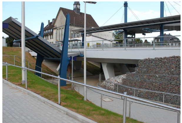
Treppenanlage Hauptzugang, Unterführung, Bahnsteigbrücke, Rampen- und Treppenanlage West, Gabionenwand
