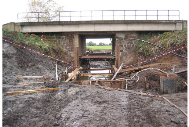
<p>Verbau und Wasserhaltung</p>
