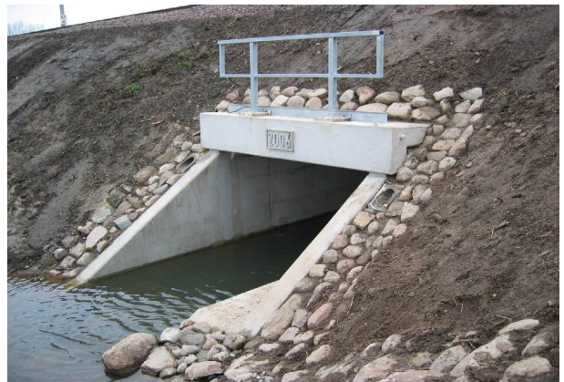
<p>Bestand nach Fertigstellung</p>
