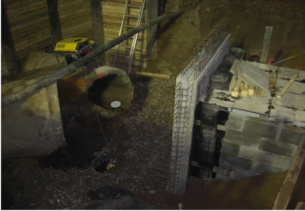
<p>Anschluss an die Regenwasserkanalisation</p>
