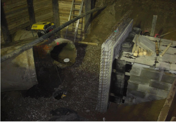
<p>Anschluss an die Regenwasserkanalisation</p>
