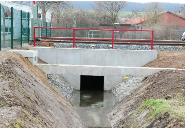
<p>Auslaufbauwerk mit Geländer und Kabelbrücke</p>
