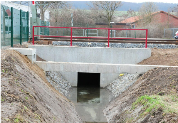
<p>Auslaufbauwerk mit Geländer und Kabelbrücke</p>
