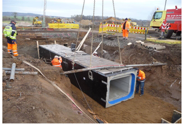
<p>Einbau der Rahmenfertigteile in einer Sperrpause</p>
