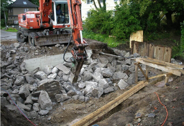
<p>Abbruch des alten Durchlasses</p>
