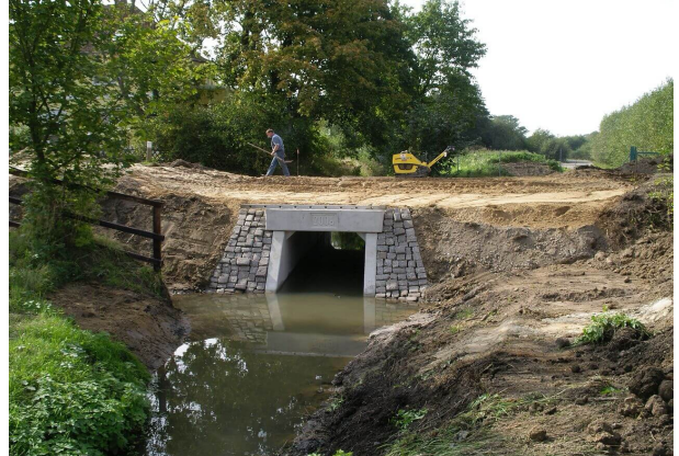
<p>Verfüllung neuer Stahlbetonrahmen</p>
