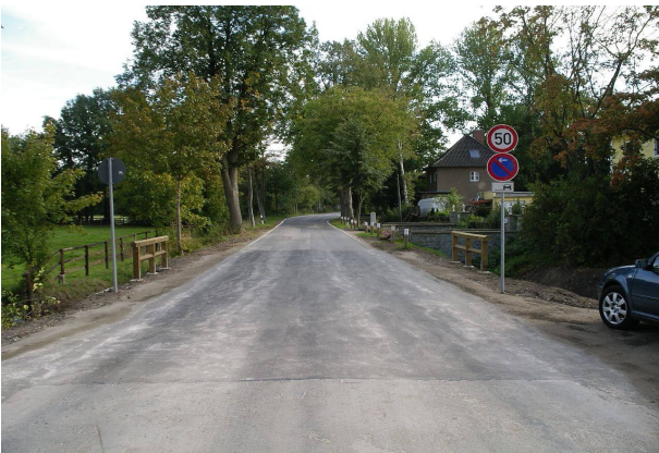
<p>Überführung einer Kreisstraße</p>
