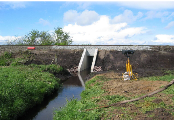
Durchlass nach der Fertigstellung
