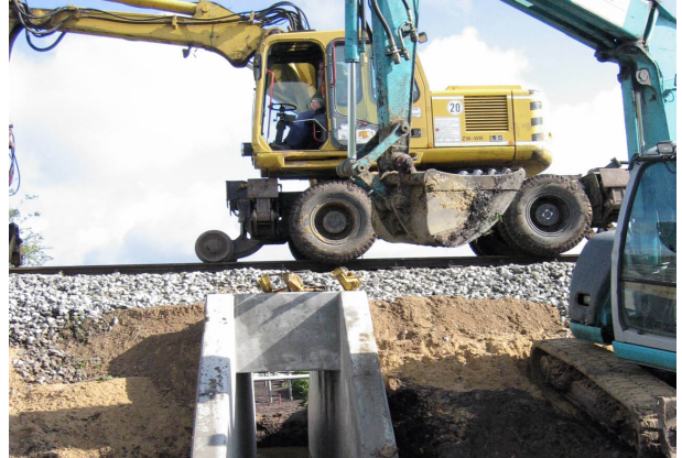
Eingebauter Fertigteildurchlass
