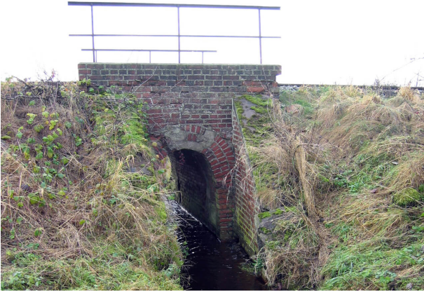
Durchlass vor der Bauausführung
