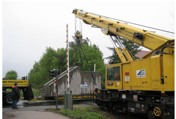
Verfahren des Betonfertigteils zur Einbaustelle
