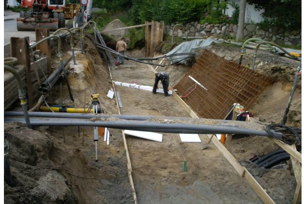
<p>Herstellung der Fundamentplatte in der Baugrube</p>
