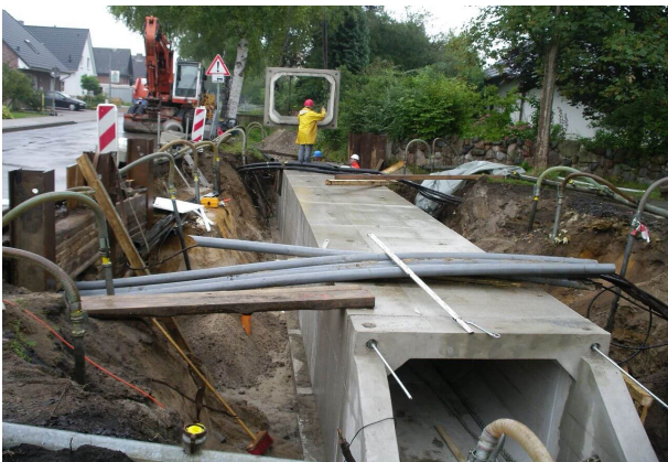
<p>Verlegen der Stahlbetonfertigteile</p>
