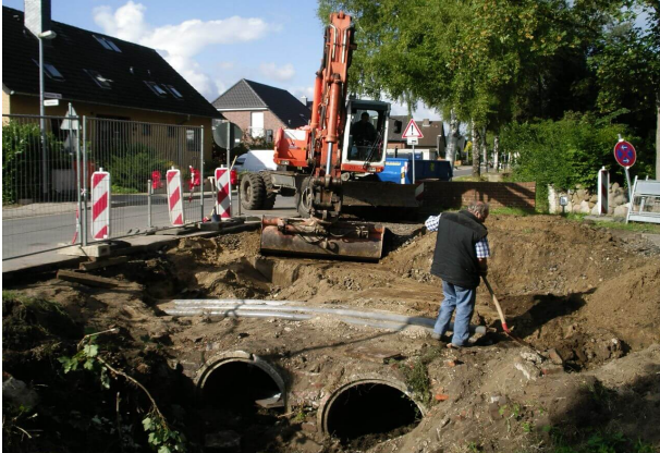
<p>Freilegen des alten Rohrdurchlasses</p>
