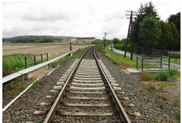
<p>Durchlass bei Fertigstellung</p>
