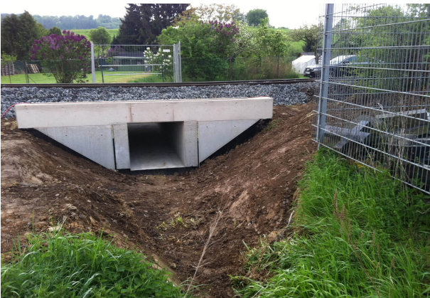
<p>Durchlass vor Inbetriebnahme</p>
