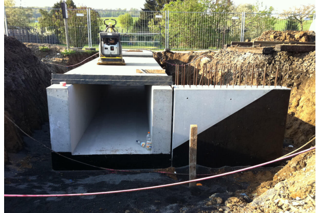
<p>Einbau der Fertigteile in die Baugrube</p>
