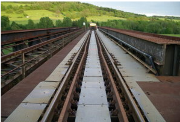
Sanierung eines vorhandenen Schienenauszuges
