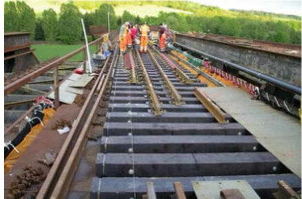
Montage und Ausrichten von Brückenbalken
