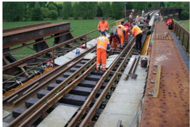
Einbau einen neuen Schienenauszuges
