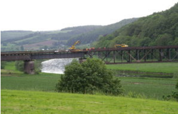
Arbeiten in großer Höhe auf der Weserbrücke
