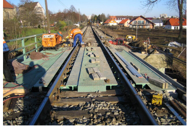
<p>Einbau der Stahlbrücke auf Spundwandkopfbalken</p><p>Einbau der Stahlbrücke auf Spundwandkopfbalken</p>
