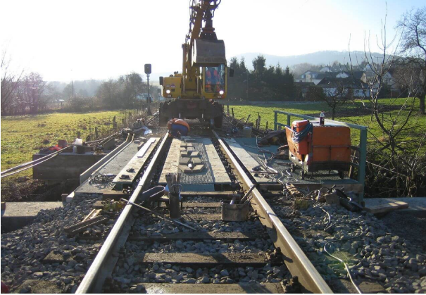
<p>Einbau der Stahlbrücke auf Spundwandkopfbalken</p><p>Einbau der Stahlbrücke auf Spundwandkopfbalken</p>
