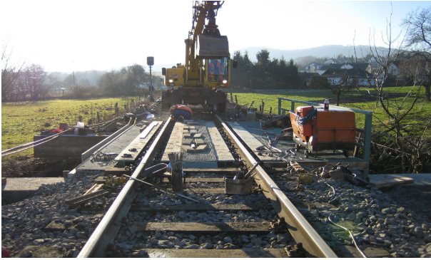
Einbau der Stahlbrücke auf Spundwandkopfbalken
