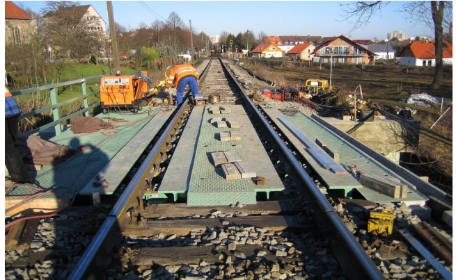
Einbau der Stahlbrücke auf Spundwandkopfbalken
