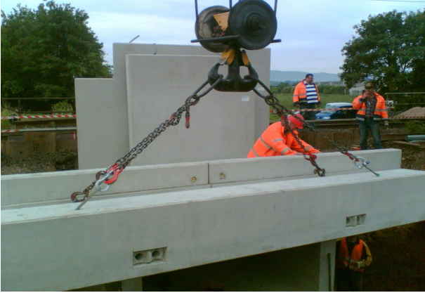
<p>Verlegen der Betonfertigteile mit einem Kran</p>
