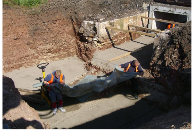
<p>Einbau der Tragschichten in der Baugrube</p>
