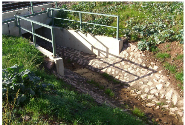
<p>Grabenprofilierung mit Wasserbausteinen</p>
