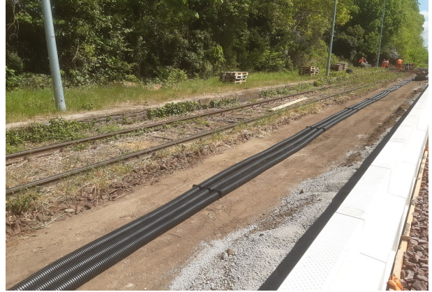
Herstellung Kabeltrasse
