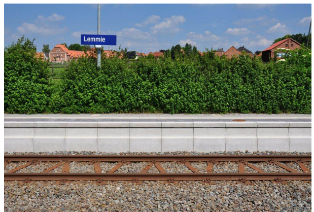
Ansicht fertiggestellter Bahnsteig
