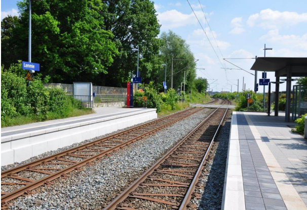
Ansicht fertiggestellter Bahnsteig
