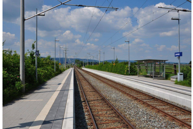
Ansicht fertiggestellter Bahnsteig
