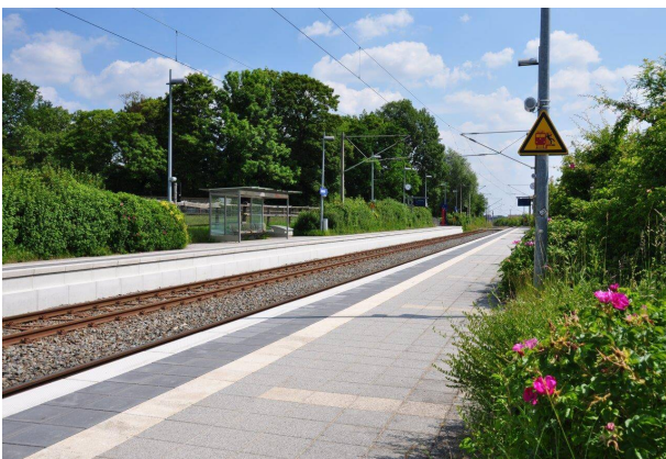
Ansicht fertiggestellter Bahnsteig
