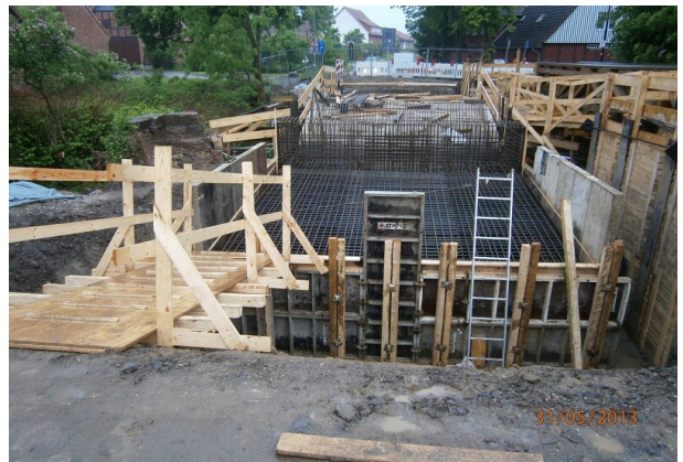
Bewehrungs- und Schalarbeiten
