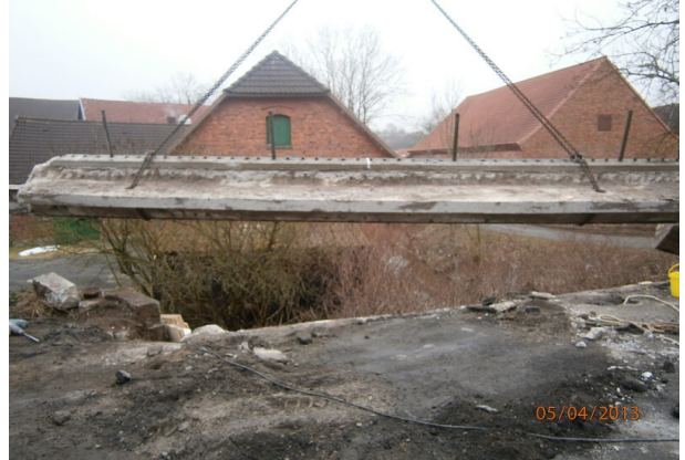
Abbau der Sandsteinbrücke
