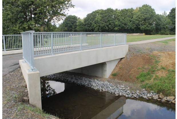
Ansicht der fertiggestellten Brücke
