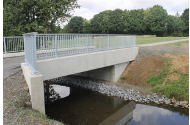
Ansicht der fertiggestellten Brücke
