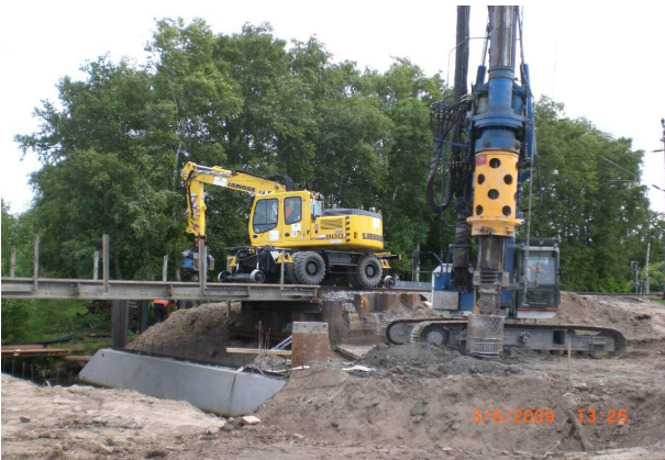
<p>Herstellung der Bohrpfehlgründung, Behelfsbrücke</p> <p>Das Brückenbauwerk über die Abelitz</p>
