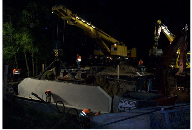
<p>Einbringen des Verbaus und der Hbr-Auflager</p><p>Versetzen von Betonfertigteilen mit Schienenkran</p>
