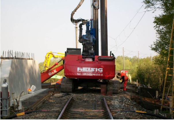
<p>Einbringen des Verbaus und der Hbr-Auflager</p><p>Versetzen von Betonfertigteilen mit Schienenkran</p>
