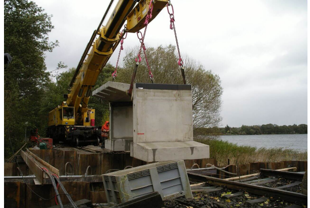
Verlegen der Betonfertigteile mit Schienenkran
