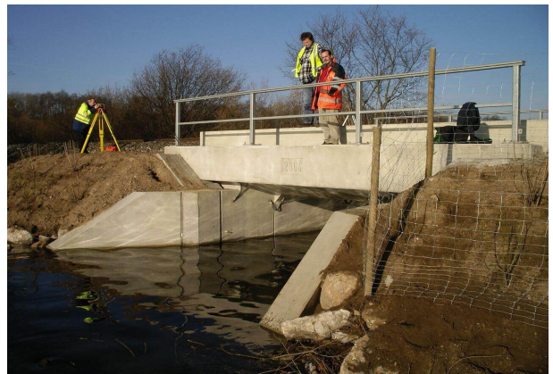
Bauwerk nach dem Ziehen der Spundwände
