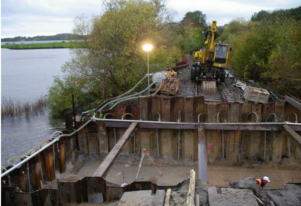
Baugrubenaushub im Verbaukasten
