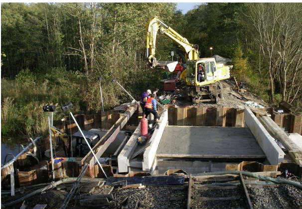
Komplett montiertes Bauwerk vor dem Verfüllen
