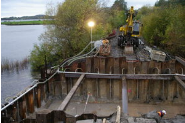
Baugrubenaushub im Verbaukasten
