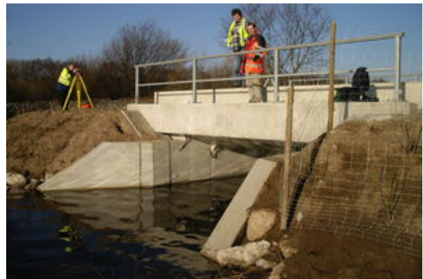
Bauwerk nach dem Ziehen der Spundwände
