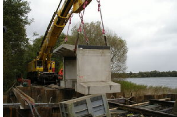
Verlegen der Betonfertigteile mit Schienenkran
