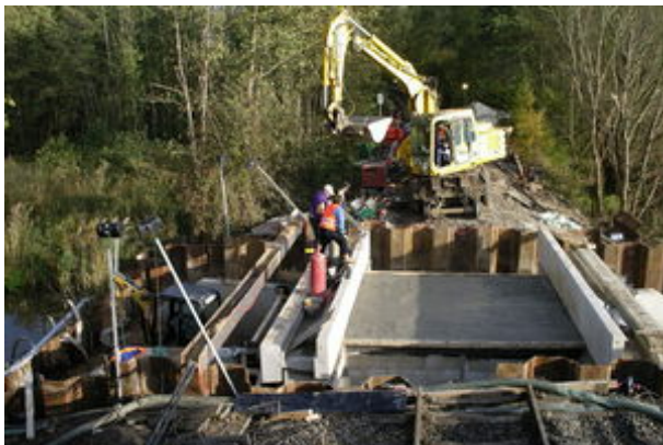
Komplett montiertes Bauwerk vor dem Verfüllen
