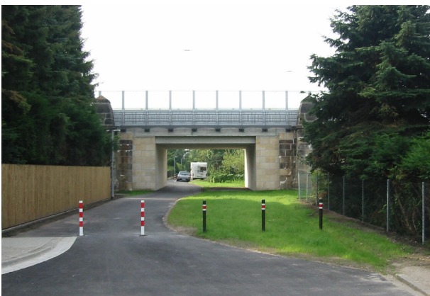
<p>Seitenansicht fertiggestellte Brücke</p>
