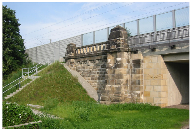
<p>Ansicht fertiggestellte Flügelwand</p>
