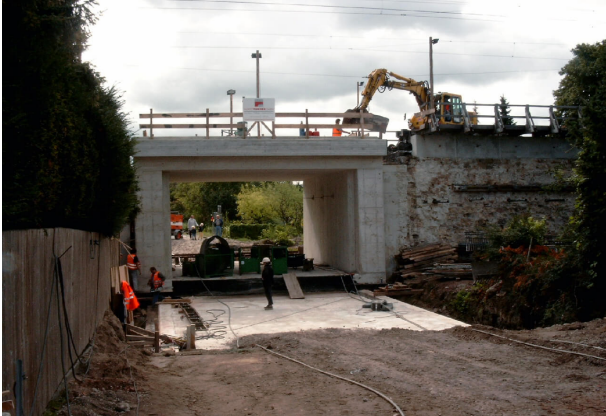
<p>Einschub des Brückenrahmens</p>
