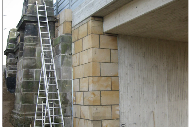
<p>Maurerarbeiten am Sandsteinmauerwerk</p>
