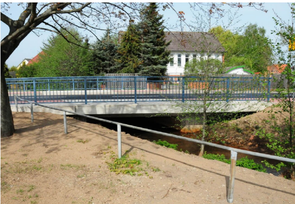
<p>Ansicht der Brücke im Verlauf des Stollenbaches</p>
