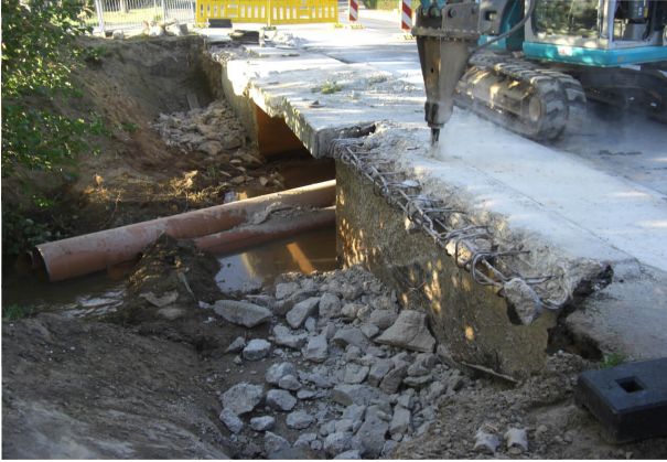
<p>Abbrucharbeiten am alten Bauwerk</p>
