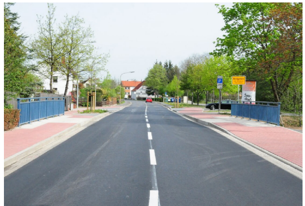
<p>Straße und Brücke nach der Fertigstellung</p>
