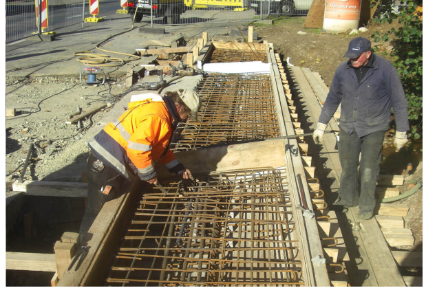
<p>Stahlbeton- und Bewehrungsarbeiten der Kappe</p>
